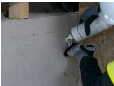
4. Apply primer to surface
