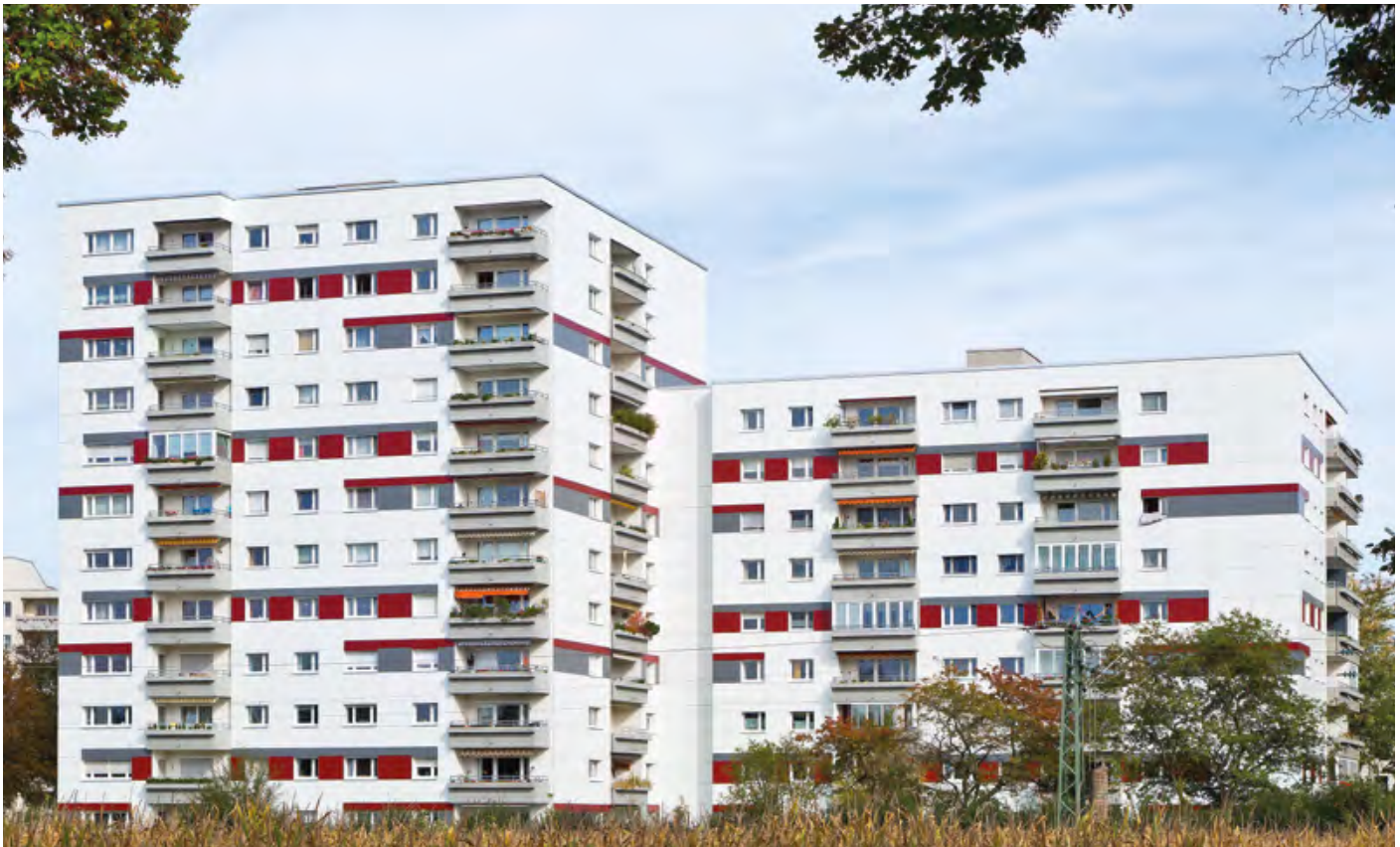
PROJECT: MAX & MORITZ, ERDING GERMANY DESIGN: KUTZSCHENBACH INGENIEURBÜRO FÜR BAUSCHÄDEN UND BAUWERKSERHALT
